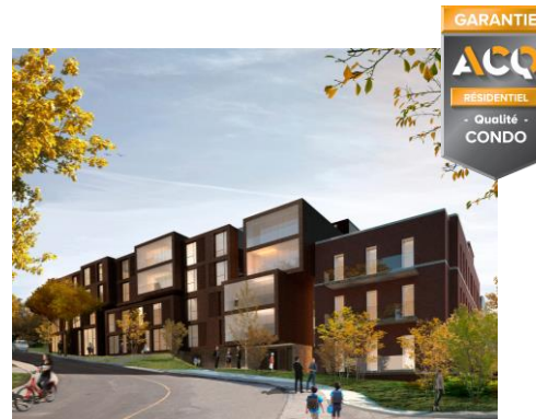
Transformation en copropriété
