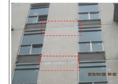
Absence d'évents décalés sous les linteaux structuraux
